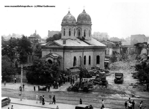
Biserica monument istoric în timpul demolării din 1987
